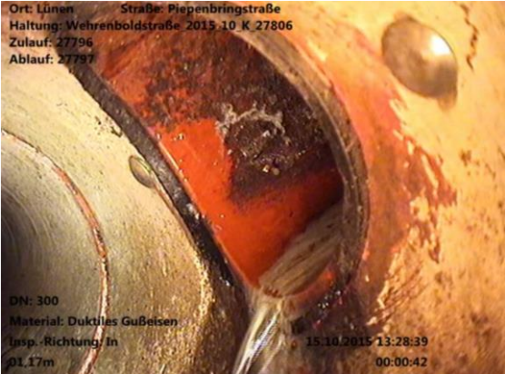
Saint-Gobain Sattelstück aus Guss
