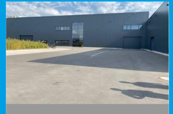
Überflutungsraum in der befestigten Fläche mittels Dreiecksprofil und Entwässerungsrinne
