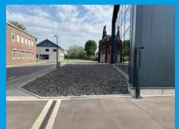
Schottermulde als Überflutungsfläche
