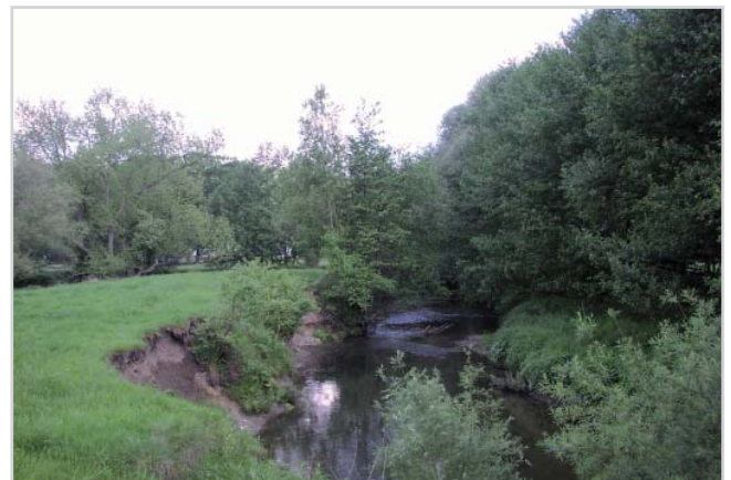
Abb. 25: Massive Sohlerosion durch Abflussverschärfung
