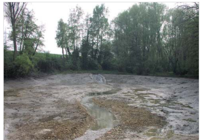
Abb. 67: Rückbau eines Teiches im Hauptschluss/Umwandlung in ein HRB mit naturnaher Gewässerentwicklung im potenziellen Staubereich
