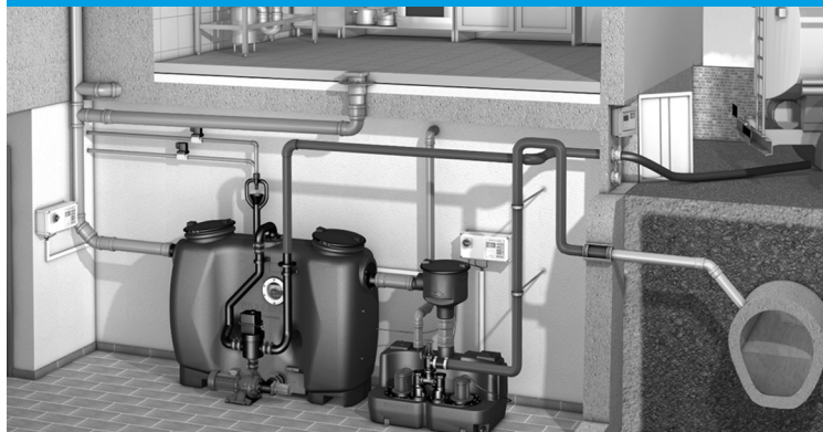
Im Keller eingebaute Fettabscheider - Anlage wird nach der Kontrolle über einen Saugwagen gereinigt.
